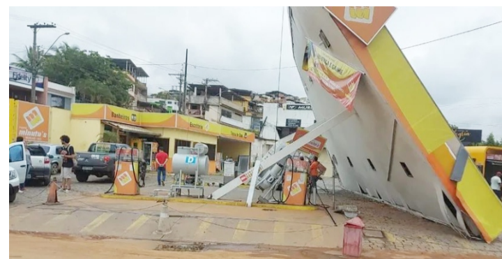
Posto de combustíveis foi destruído durante vendaval em Muriaé Foto: Larissa Zimmermann/TV Integração
