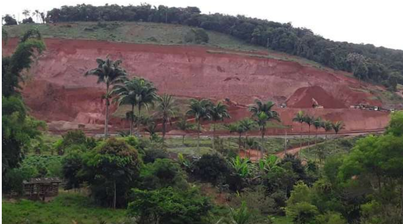
Figuras 15 a 18 – Situação da intervenção na referida área em março de 2021.
