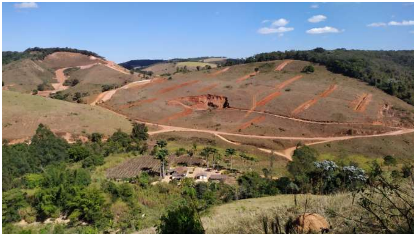
Figuras 7 a 12 – Início dos trabalhos da ZMM na área em questão.
